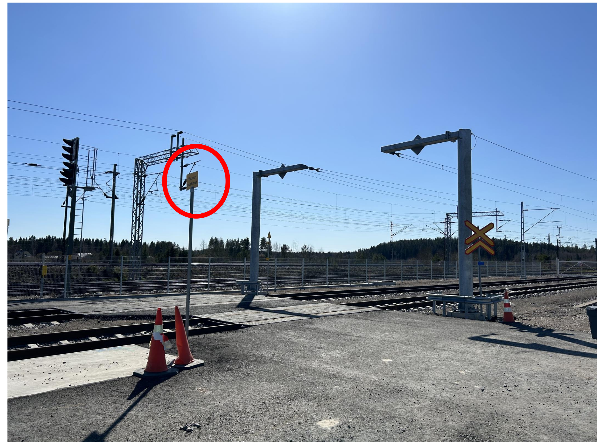
Kuvassa ympyröitynä r. 907 vaunujen kohdistuspaikkamerkki.
